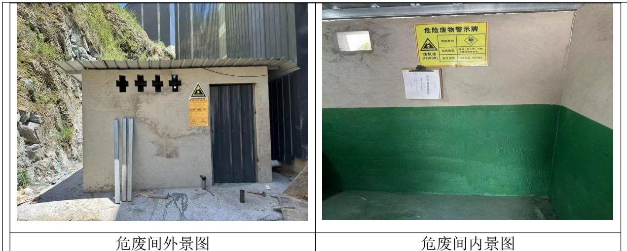
图 3-4 危废间现场图
