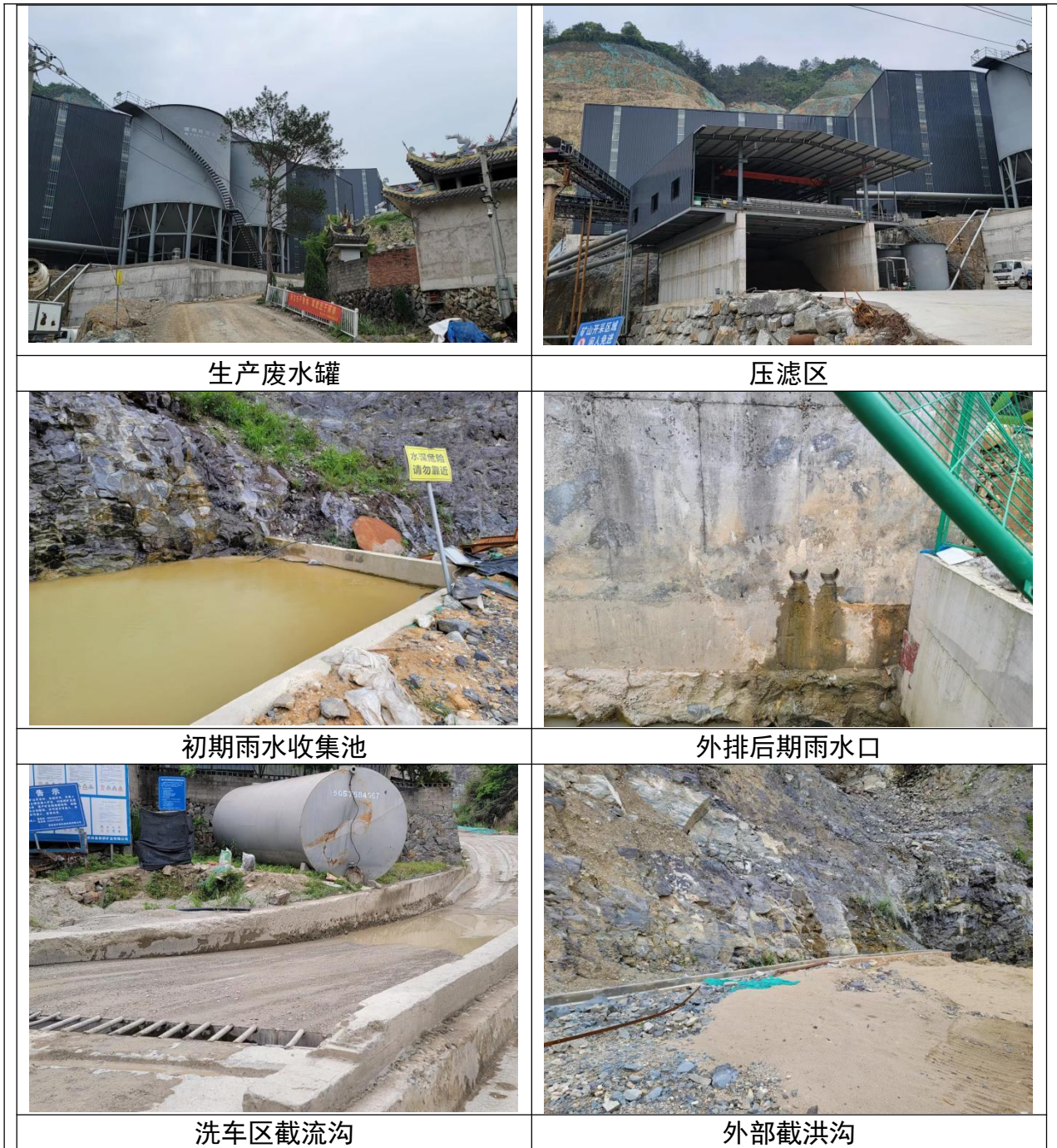
图 3-1 污水产污节点和处理设施
